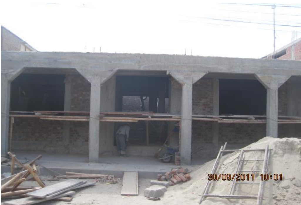
FOTO N°-01 SE APRECIA LA COLOCACIÓN DE ANDAMIOS PARA TARRAJEO DE CIELO RASO
