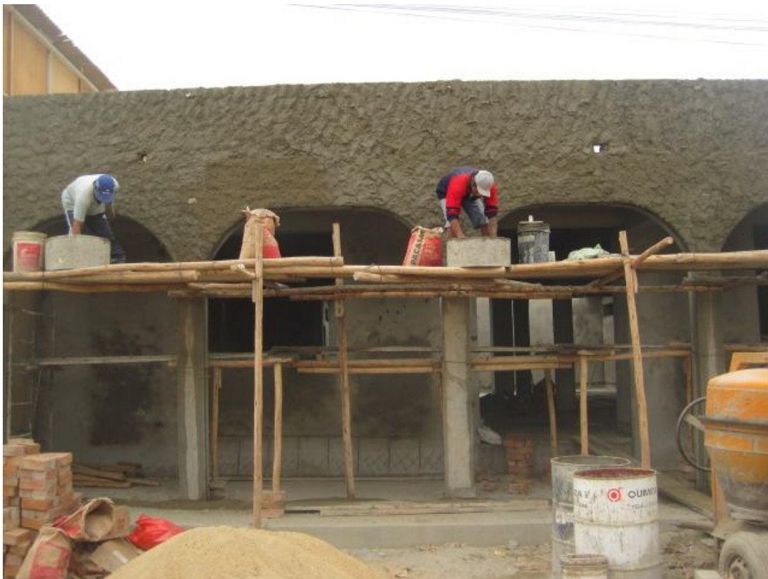
FOTO N°03-TARRAJEO DE MUROS EXTERIORES CON CEMENTO-ARENA FINA
