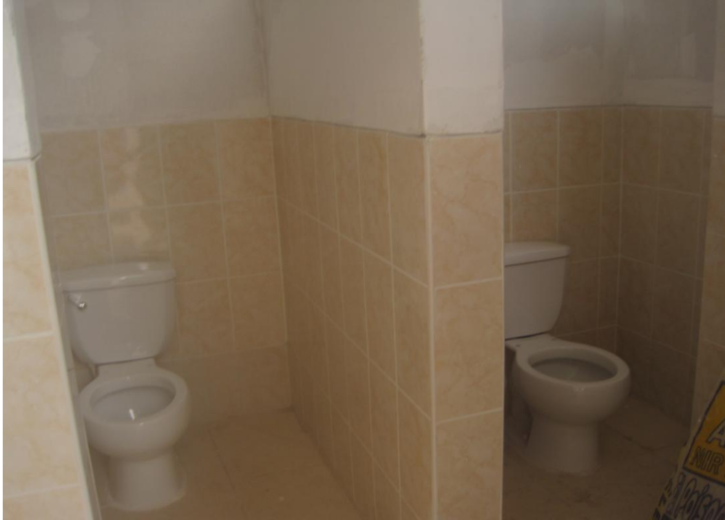
FOTO N°08-APARATOS SANITARIOS Y CONTRAZÓCALOS DE CERÁMICOS EN SS.HH.
