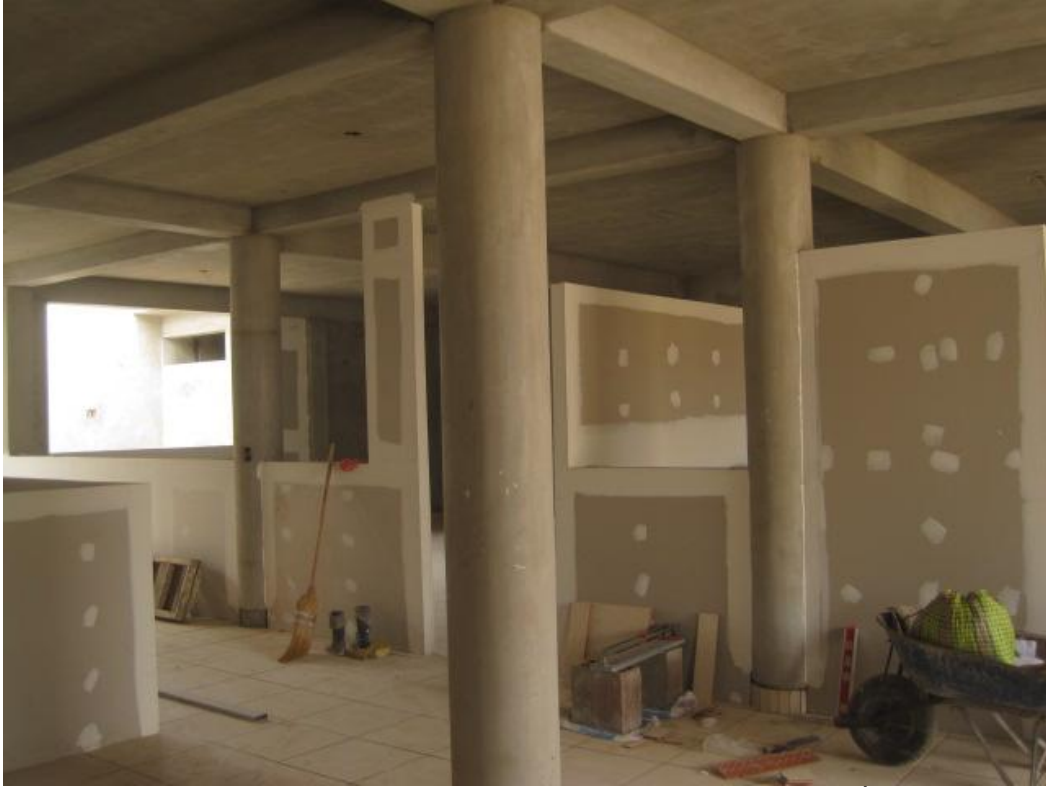
FOTO N°04- SE APRECIA LOS TABIQUES DE DRYWALL COLOCADOS SEGÚN PLANOS DE ARQUITECTURA
