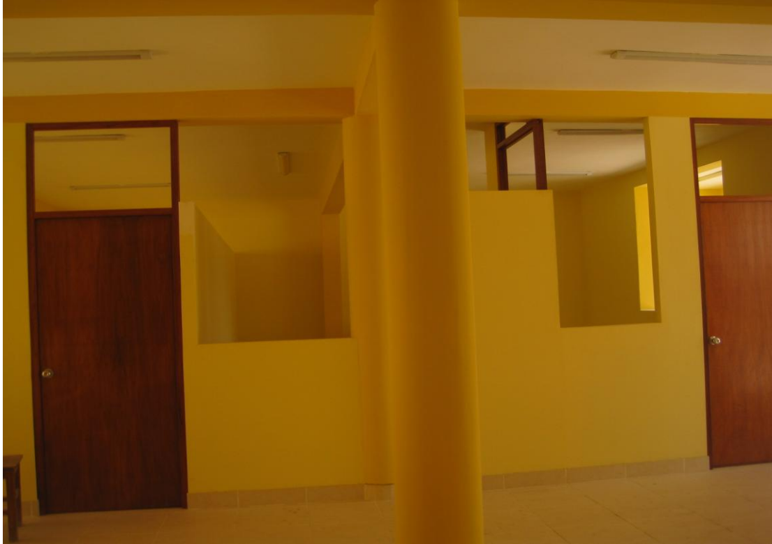
FOTO N°06- PINTADO DE MUROS Y COLOCACIÓN DE PUERTAS CONTRAPLACADAS EN AMBIENTES
