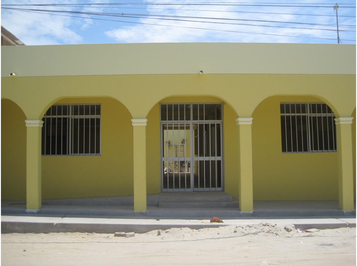
FOTO N°10- VISTA EXTERIOR DEL LOCAL MUNICIPAL CONCLUIDO AL 100%
