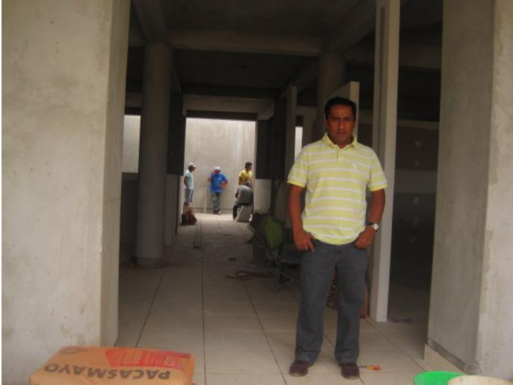
FOTO N°05- SE APRECIA LOS TARRAJEOS DE MUROS INTERIORES Y PISO DE CERÁMICO CONCLUIDOS AL 100%
