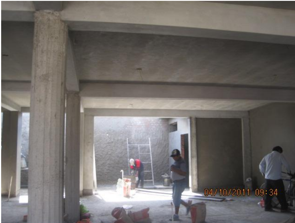
FOTO N°02-TARRAJEO DE MUROS INTERIORES COLUMNAS Y VIGAS
