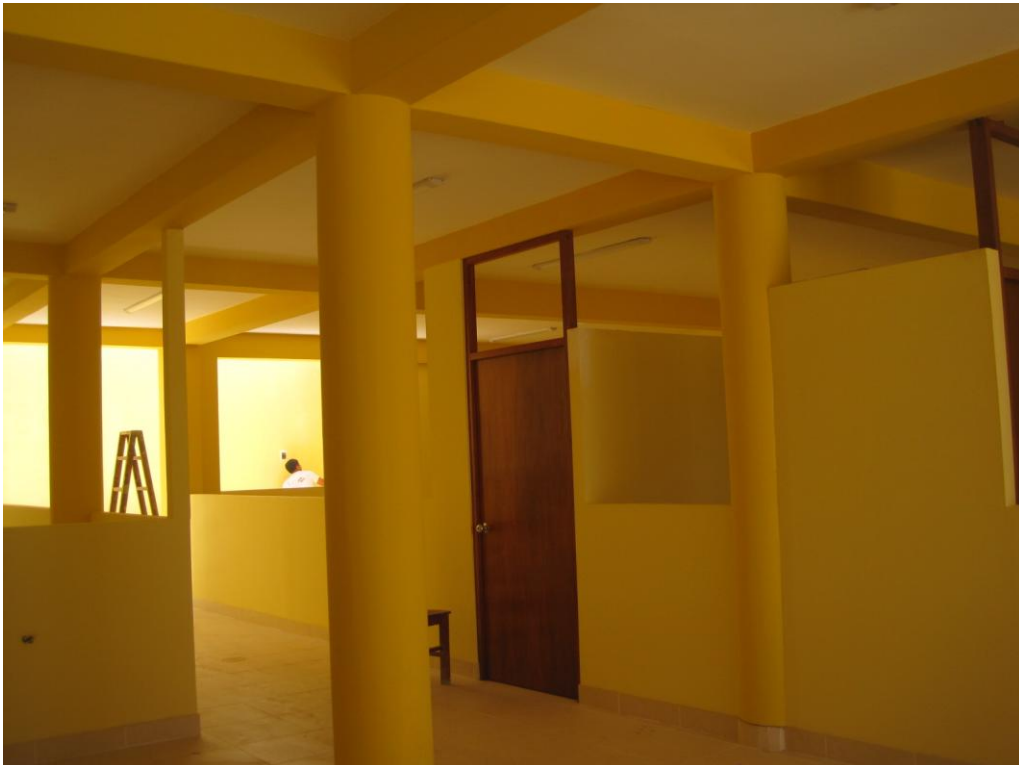
FOTO N°07- SE CULMINAN TRABAJOS DE PINTADO DE MUROS Y PUERTAS CONTRAPLACADAS
