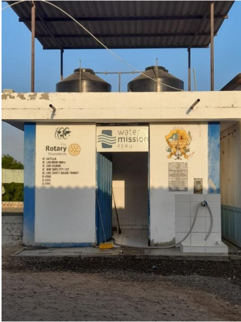
CASETA PROCESADORA DE AGUA SEGURA-STA. ELENA
