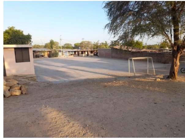
PLATAFORMA DEPORTIVA-STA. ELENA
