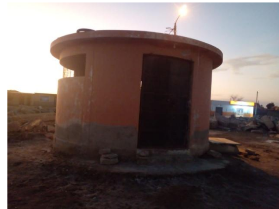
CASETA DE REBOMBEO DE AGUAS SERVIDAS-ALCANTARILLADO CASAGRANDE
