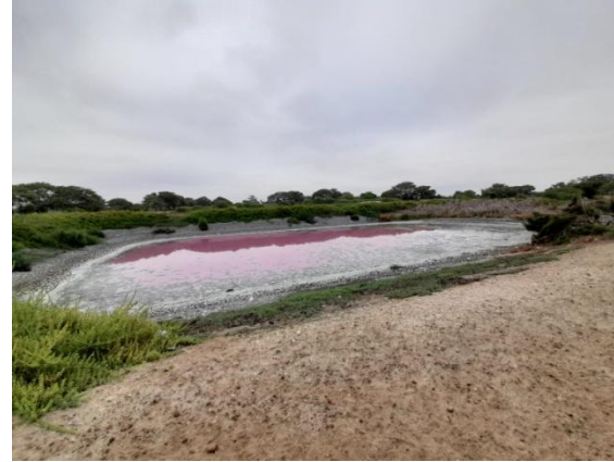
LAGUNA DE OXIDACIÓN
